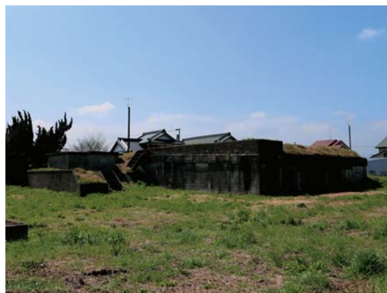
半地下式コンクリート造建物(宇佐市史跡) 受信所か？
